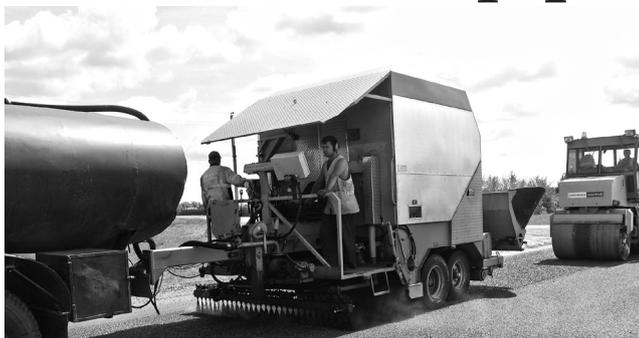
«Лицо, состоящее при женихе или невесте в свадебной церемонии» согласно словарю Ушакова называется шафер. Такое же название имеет немецкая фирма, производящая дорожную технику. Изображенная на снимке машина (единственная в нашей Республике!) позволяет наносить на имеющееся дорожное покрытие защитный укрепляющий слой, или «слой износа», продлевающий жизнь асфальтобетону на несколько лет.
